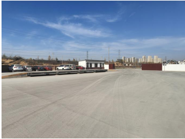
厂区进出口及地面
