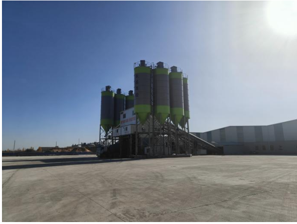
搅拌楼和筒仓
