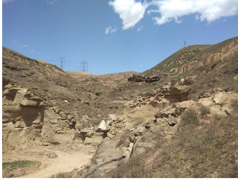
照片 2.5-1 330kv 输电线路 镜向 280°
