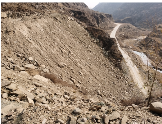
照片 3.2-4 P1 不稳定边坡 镜向170°
