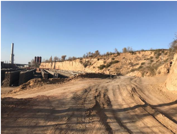
照片 3.2-1 B1 崩塌南侧 镜向 320°
