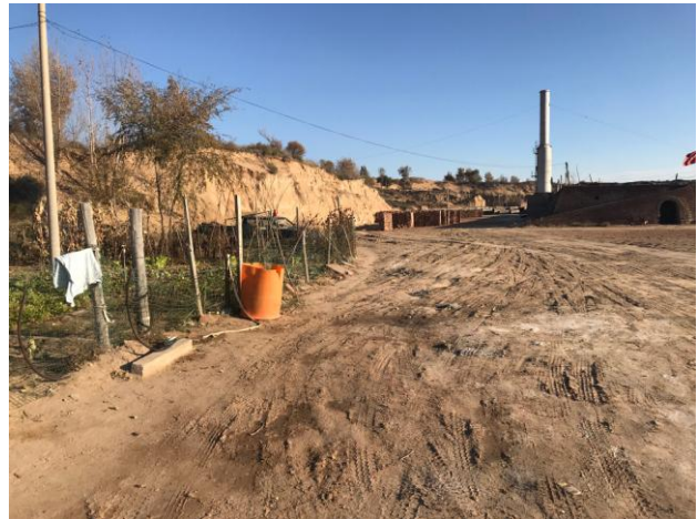
照片 3.2-2 B1 崩塌北侧 镜向 150°
