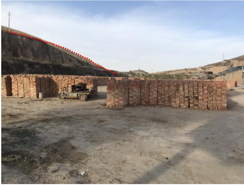
照片 3.2-1 B1 崩塌西侧 镜向 280°
