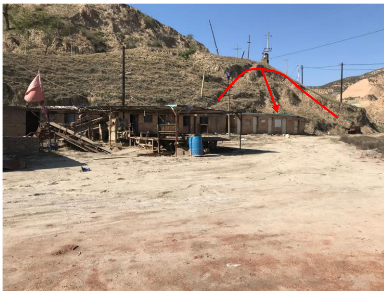
照片 3.2-1 H1 滑坡隐患 镜向 300°
